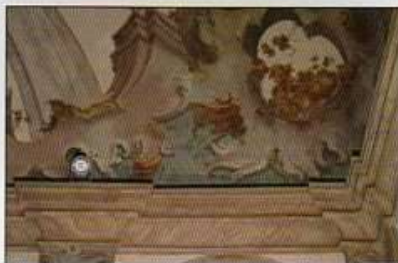
Particolare dopo il restauro.
