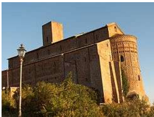
L'esterno e l'abside
