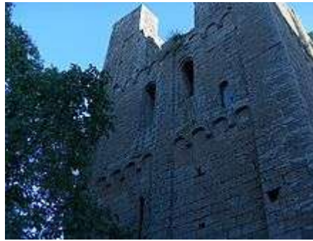
La torre campanaria
